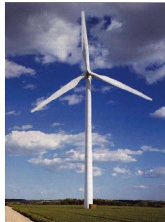
L'**éolienne à axe horizontal** est munie de pales (généralement deux ou trois) qui tournent dans un plan vertical. Ainsi l'éolienne doit s'orienter face au vent pour une bonne efficacité. C'est l'éolienne la plus courante.
