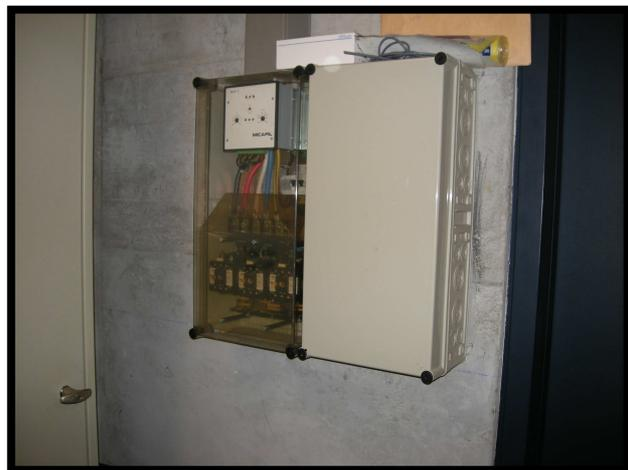
Figure 10 - Régulateur de courant , qui transforme le courant qui arrive en alternatif en courant continu pour alimenter les installations du gymnase.
